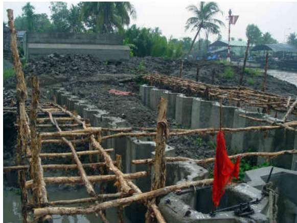
Hình D2: Thi công dầm giằng đầu cừ cổng lắp ghép
