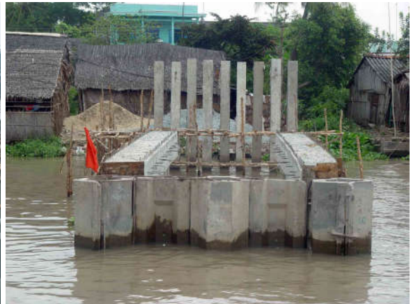
Hình D2: Thi công dầm giằng đầu cừ cổng lắp ghép
