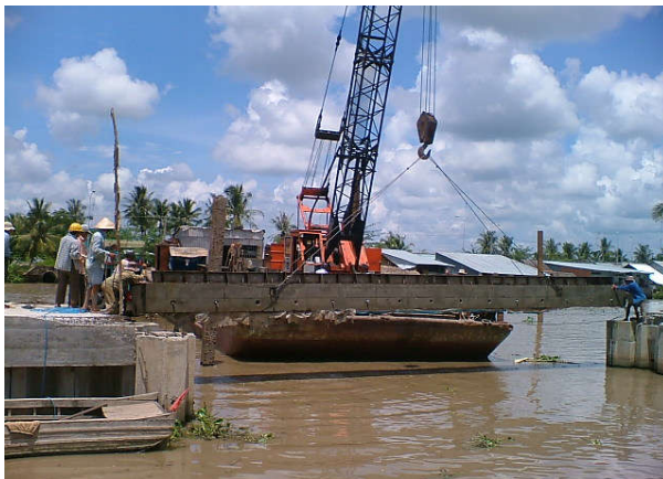
Hình D3: Thi công lắp đặt dầm van, cửa van
