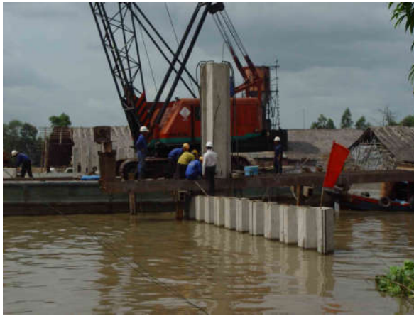
Hình D1: Thi công đóng cừ bản BTCT dự ứng lực
