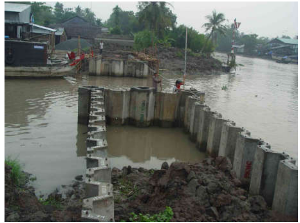
Hình D1: Thi công đóng cừ bản BTCT dự ứng lực
