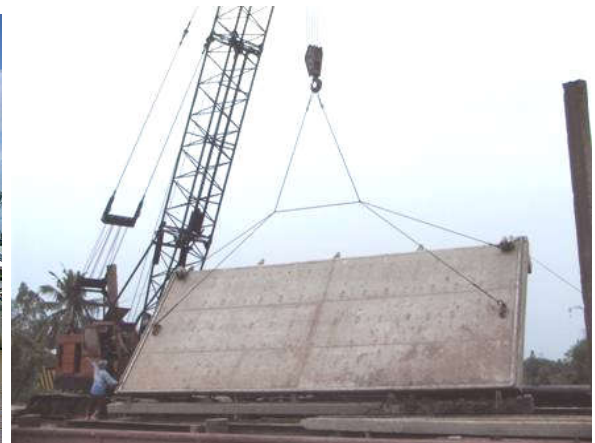
Hình D3: Thi công lắp đặt dầm van, cửa van
