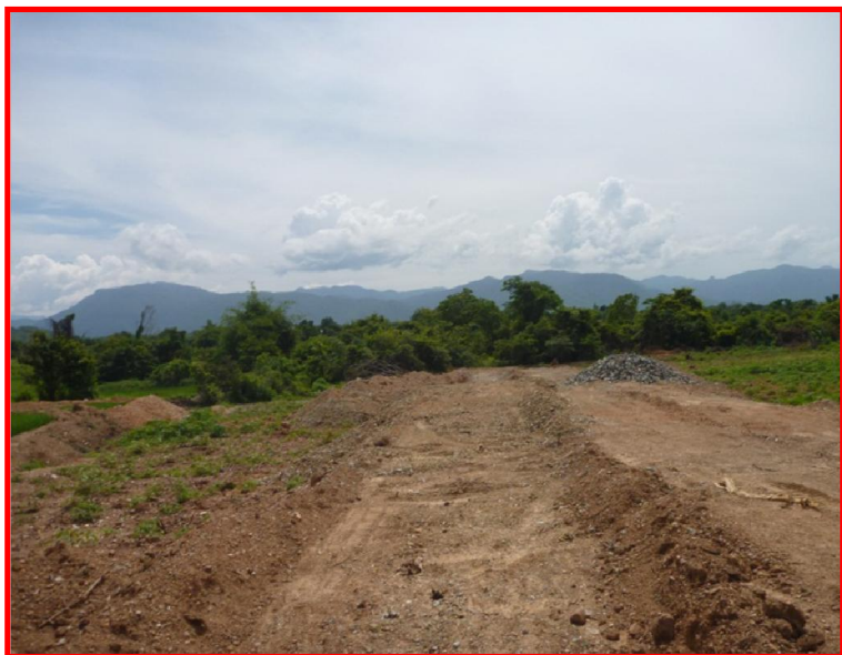
① Trước thi công
