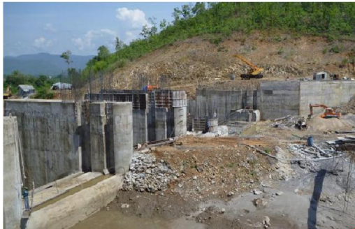
Công trình đầu mối Sông Lũy
