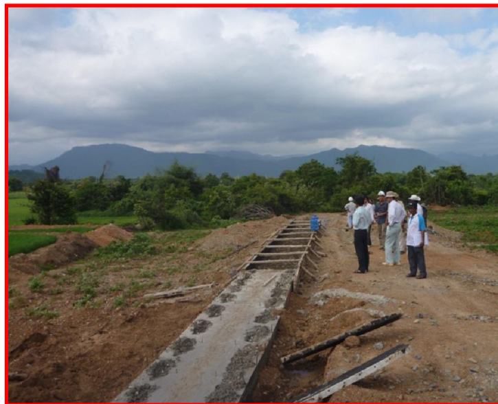
② Đang thi công
