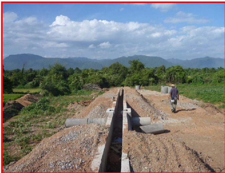
③ Sắp hoàn thành
